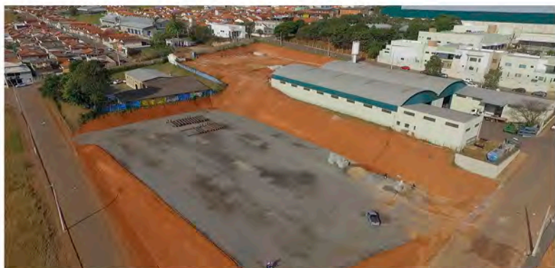
O terreno na esquina de baixo da COOMAP, que passou por terraplanagem e foi coberto de brita, para obras futuras.
