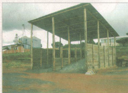
Silo de Calcário
