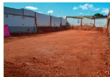
Terreno completamente limpo para o início das obras.
