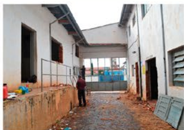
Início da demolição da sede antiga.
