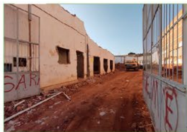
Demolição em progresso.
